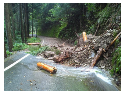
由良野に登ってくる 道も土砂崩れ。危う いところでした。
