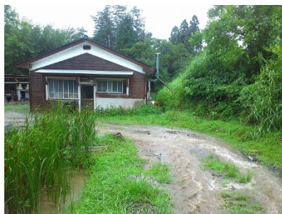
道のワダチを削りながら一気に 工房に向かって流れる雨水。
